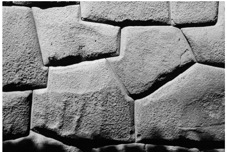
Abbildung 2: Zyklopenmauer in Cuzco, Peru. Spuren von „Maurerkellen“, s.u.
